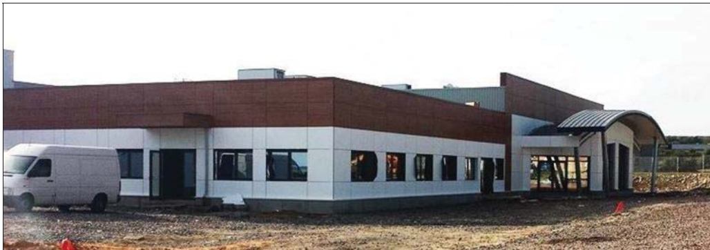
L'Esat en construction sur le district urbain de Faulquemont. Photo DR
