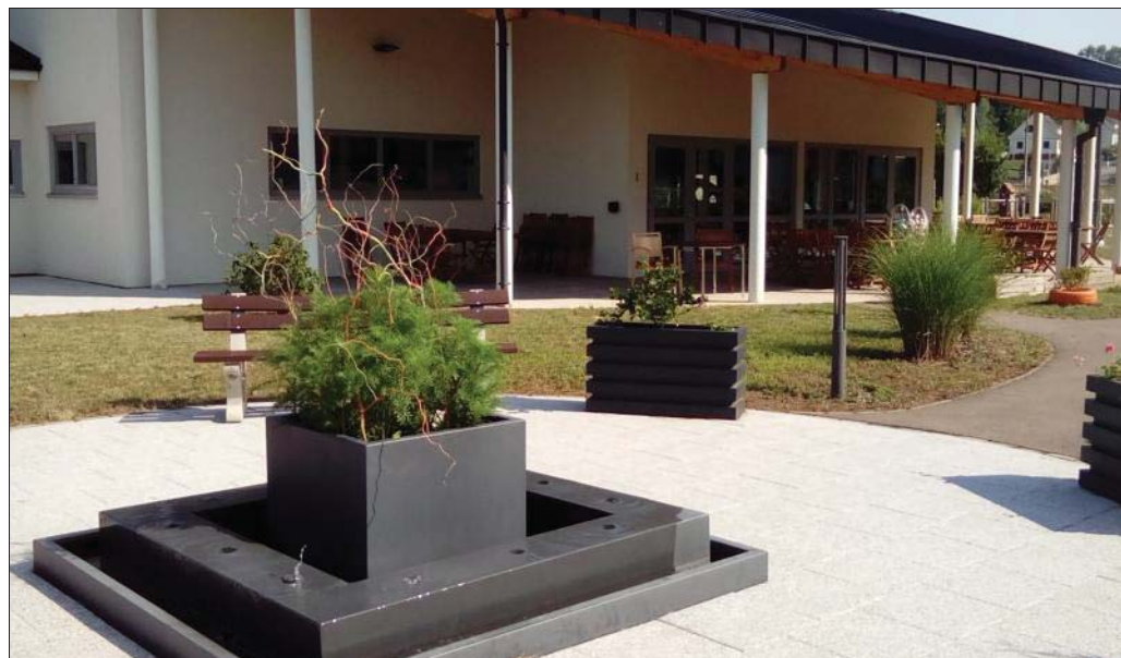
Depuis plus de cinq années, le FAS/FAM situé rue Principale à Marienau accueille des personnes en situation d'handicap mental. Photo RL
